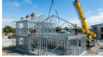
3. ADIM (6–8. Gün) Kaset Döşeme & Çatı Makasları
