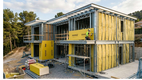
Paket 2: Frame + Insulation (İskelet + Yalıtım & Kaplama)
