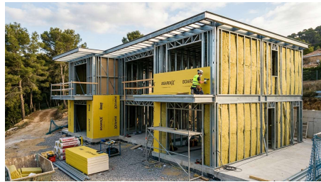
Paket 2: Tragwerk + Dämmung (Frame + Sheathing + Insulation)
