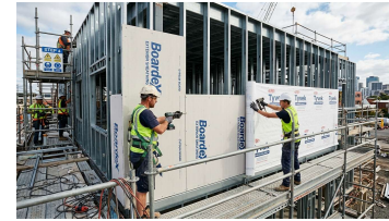
SCHRITT 4 (Tag 9–12) Beplankung & Unterspannbahn
