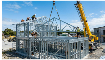
SCHRITT 3 (Tag 6–8) Kassettendecke & Dachstühle
